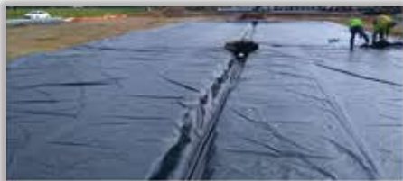
HDPE Geo Membrane
